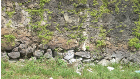
Muro de calicanto, con juntas de piedra disgregadas por afectaciones incrustación de plantas.
