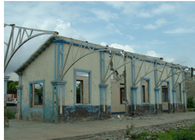
Afectaciones por abandono Antigua Estación del Ferrocarril, Managua
