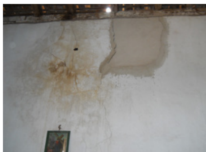
Afectaciones por humedad
