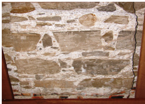
Catedral de León, muro de calicanto
