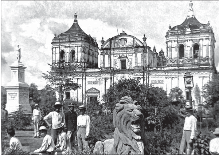
Catedral de León a inicios del siglo XX. Allí Darío fue bautizado el 3 de marzo de 1867 y enterrado el 13 de febrero de 1916.
