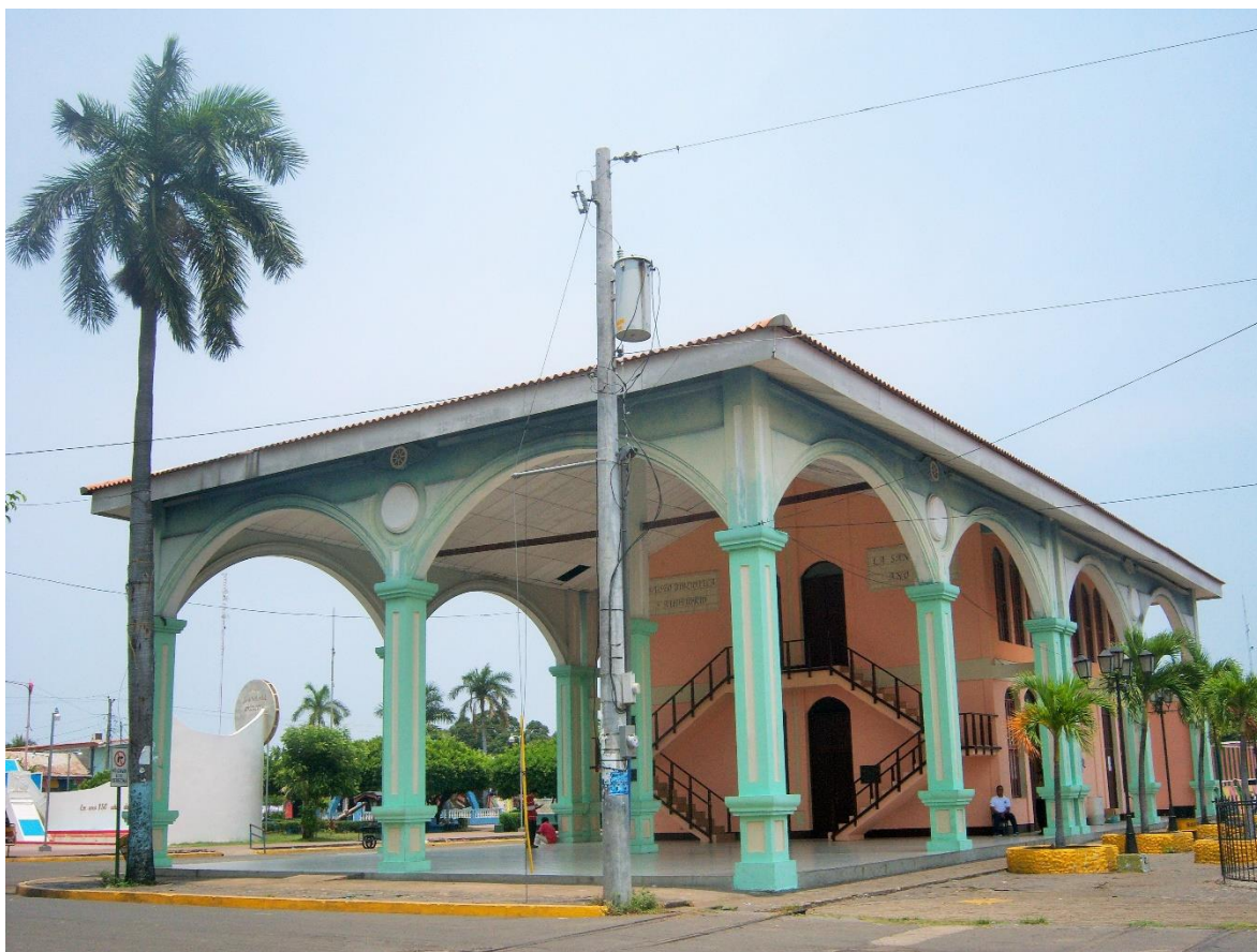
Edificio de la Biblioteca Pública de Corinto (antigua Estación del Ferrocarril). Fuente: INC
