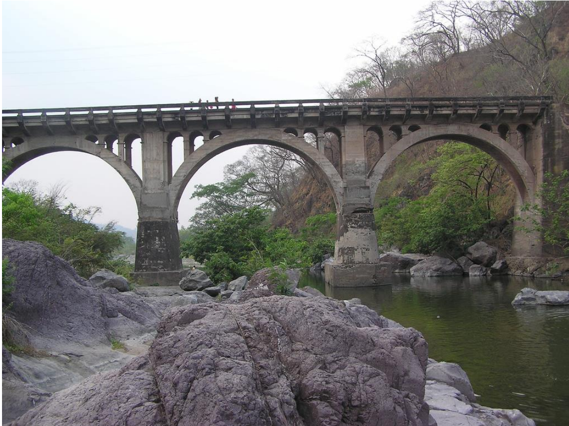
Puente del Ferrocarril sobre el Rio Grande, El Sauce
